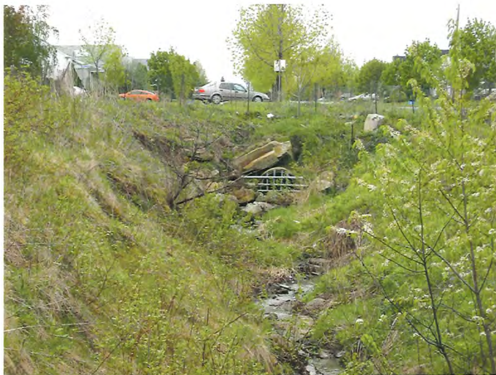
Photo 8 (18-05-2007) : Vue du cours d'eau Madore à sa canalisation sur la rue Rivelaïne.
