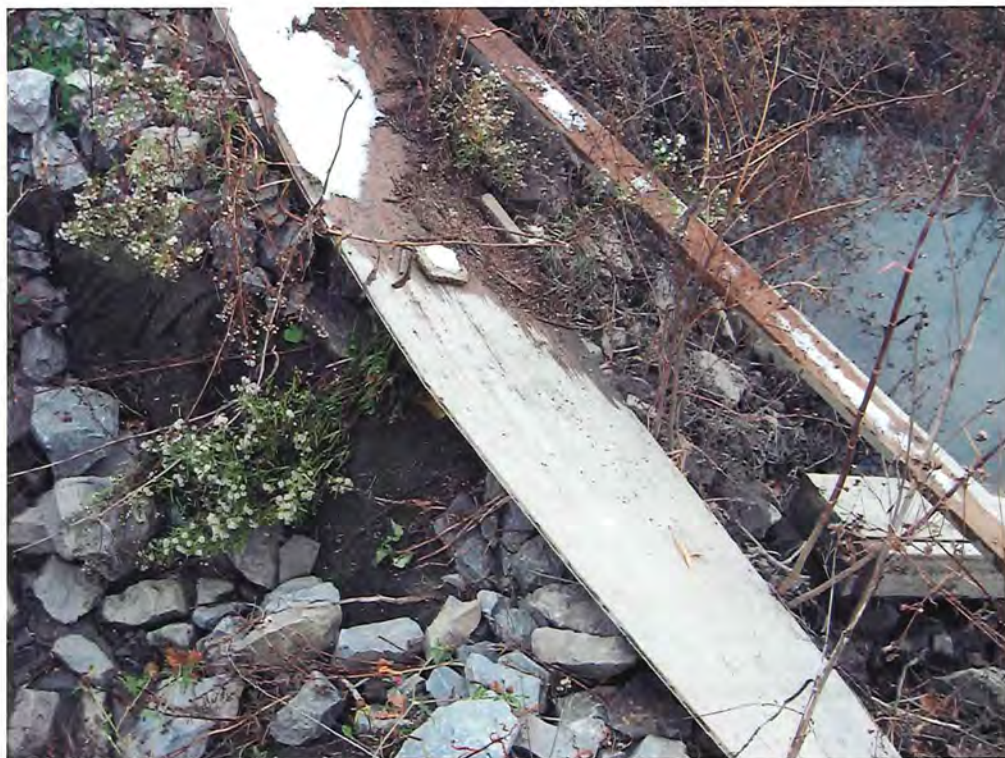
Photo 13 (30-10-08) : Vue du point de remblai dans le cours d'eau Madore.
